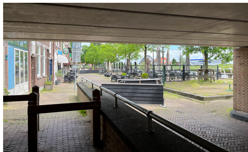
Brugdoorgang: obstakels belemmeren doorgang voetgangers en fietsers.
